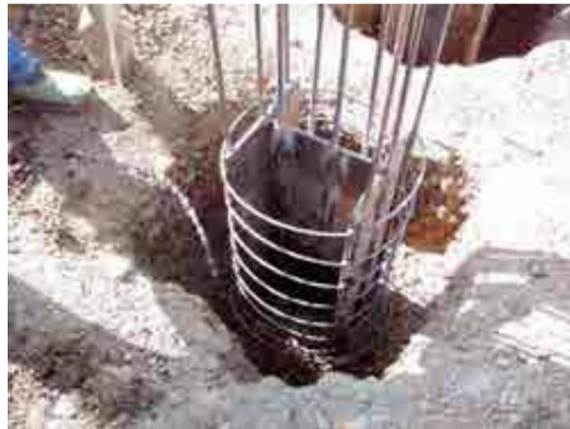
Fotografía 4. Vista de unión pilote metálico encepado conforme detalle de la figura 10.
