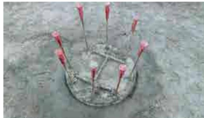
Fotografía 5. Detalle de armadura para transferir carga de tensión del pilote al encepado.
