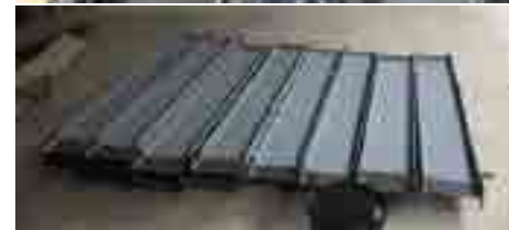
Aplicación de pintura anticorrosiva.
