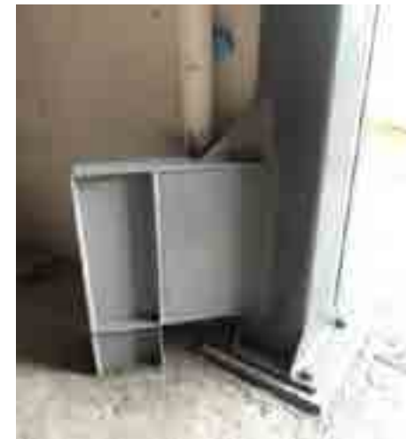
Conexión entre pilote y columna exterior.
