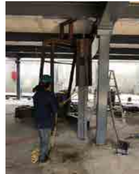
Hincado de vigueta interior.
