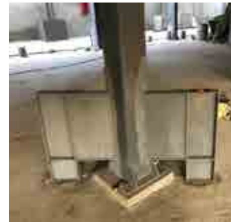
Conexión entre pilotes y columna central.
