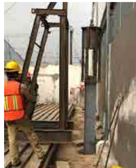
Hincado de vigueta exterior.
