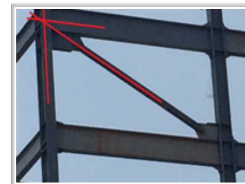
a) Marco con contravientos concéntrico
