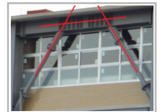
b) Marco con contravientos excéntricos
