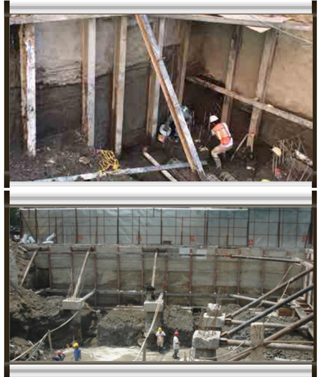
**(E) Celdas entre Vigas Verticales:** Para la protección del corte se tienen varias opciones las cuales dependen del tipo de suelo y de la separación de las vigas verticales, las diferentes alternativas se enlistan a continuación, sin embargo en este artículo en la descripción del procedimiento constructivo del sistema de muro Berlín se hace referencia a la opción 1:
