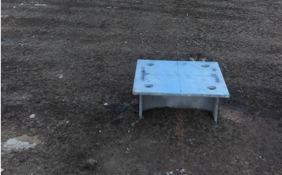
Conexión pilote-columna.
