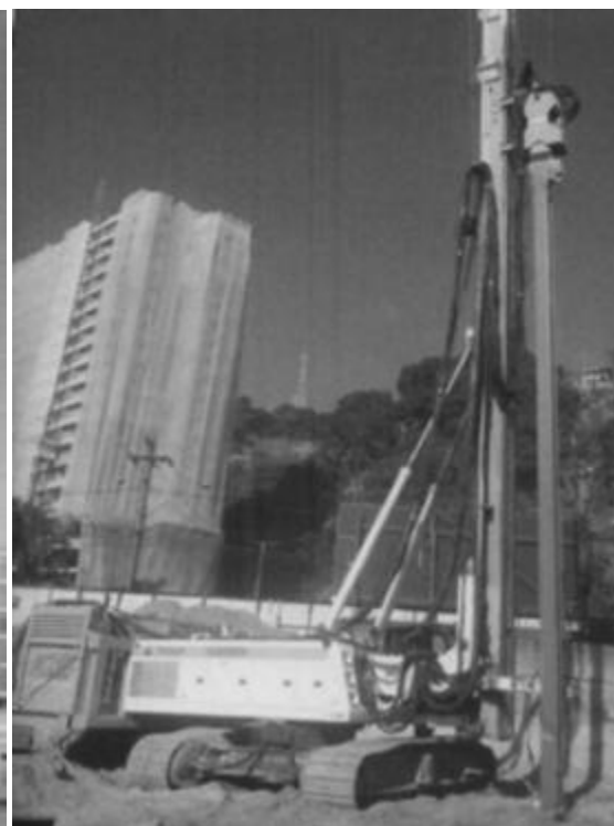
Fotografía 7. Martillo vibratorio hidráulico.
