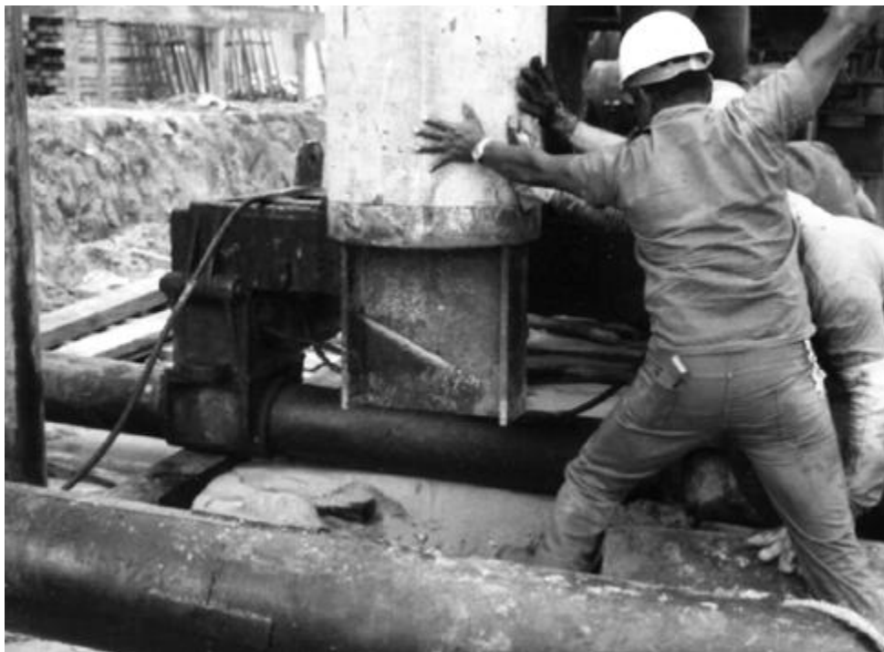
Fotografía 2. Pilote mixto (concreto-perfil metálico), para apoyo en roca.
