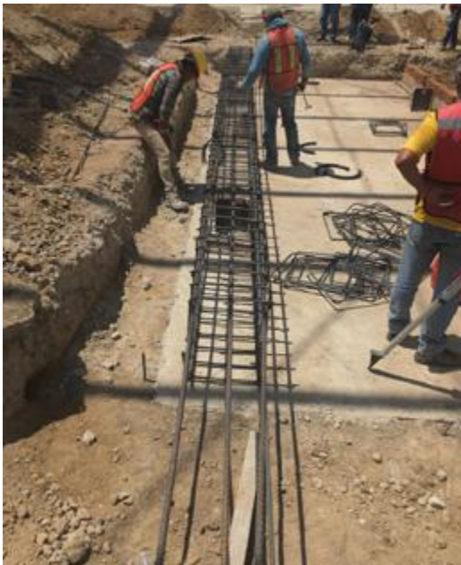
Conexión pilotes contratrabes.
