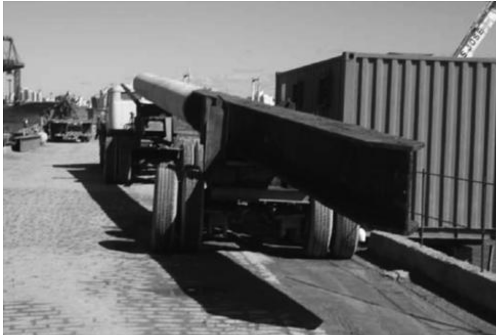
Fotografía 1. Pilote mixto (concreto-perfil metálico), para atravesar suelos rígidos sin desplazamiento de terreno.
