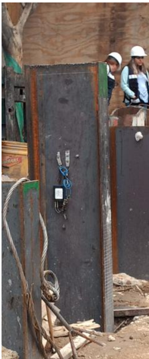
Instrumentación de pilote.
