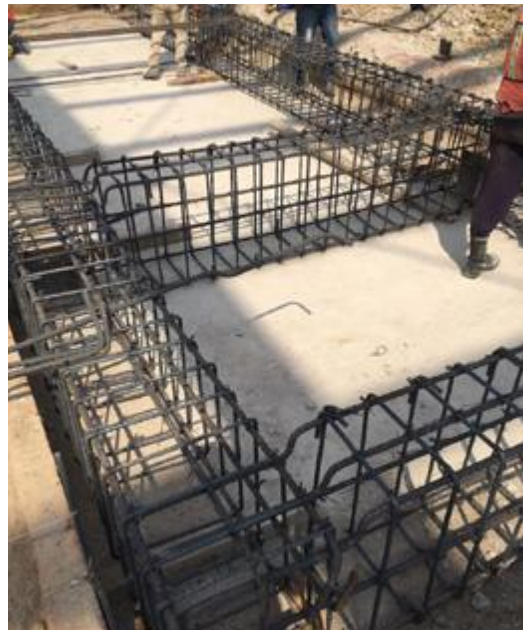
Conexión pilotes contratrabes.
