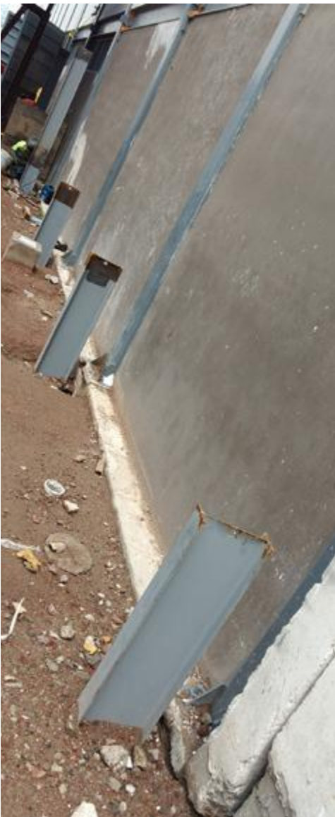
Arreglo de pilotes.
