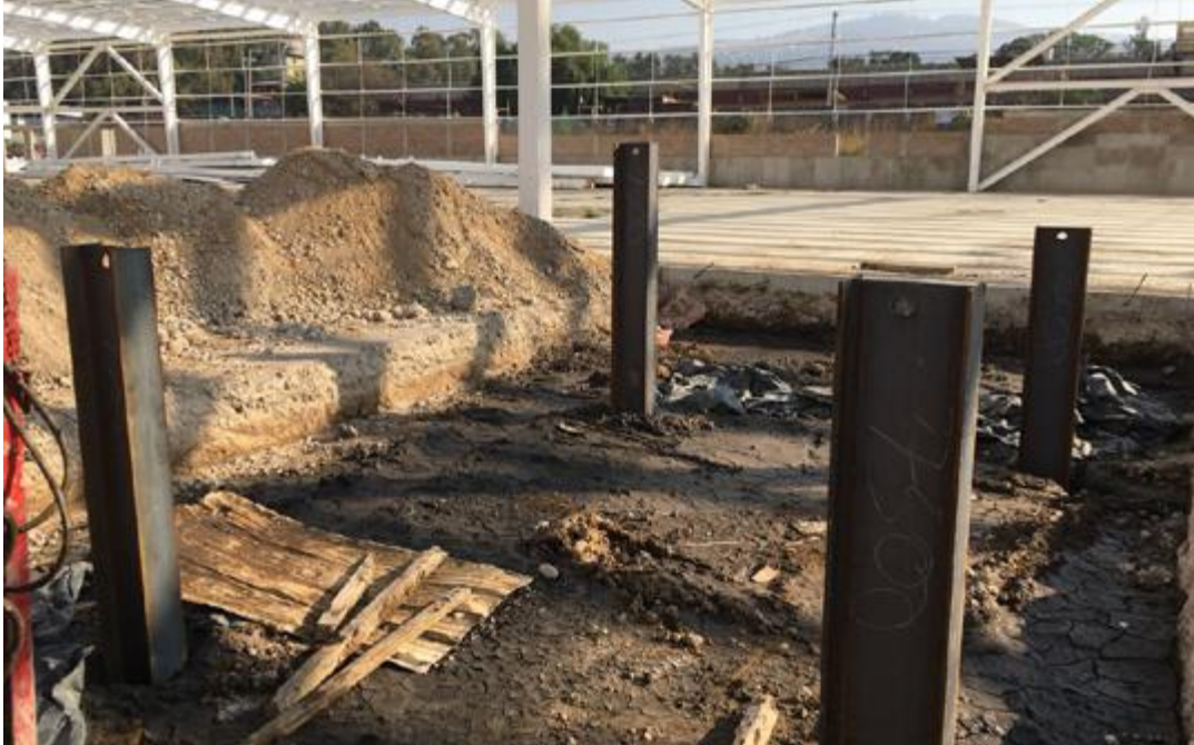
Arreglo de pilotes.
