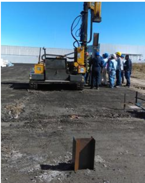
Equipo de hincado de pilotes
