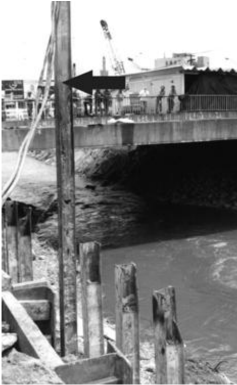
Fotografía 3. Pilote metálico del Puente Wandenkolk, removido después de más de 20 años de uso.
