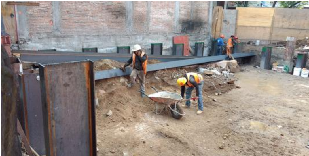
Arreglo de pilotes.
