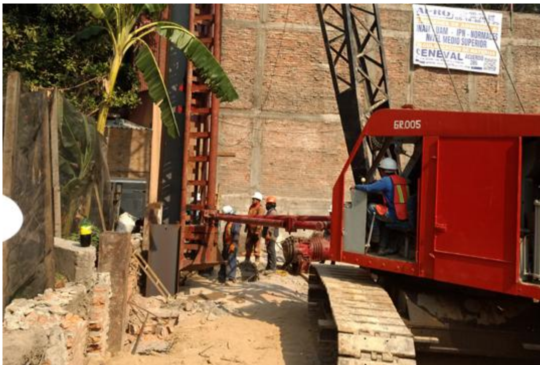
Equipo de hincado de pilotes.
