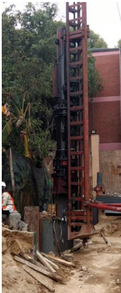
Aplicación de carga.
