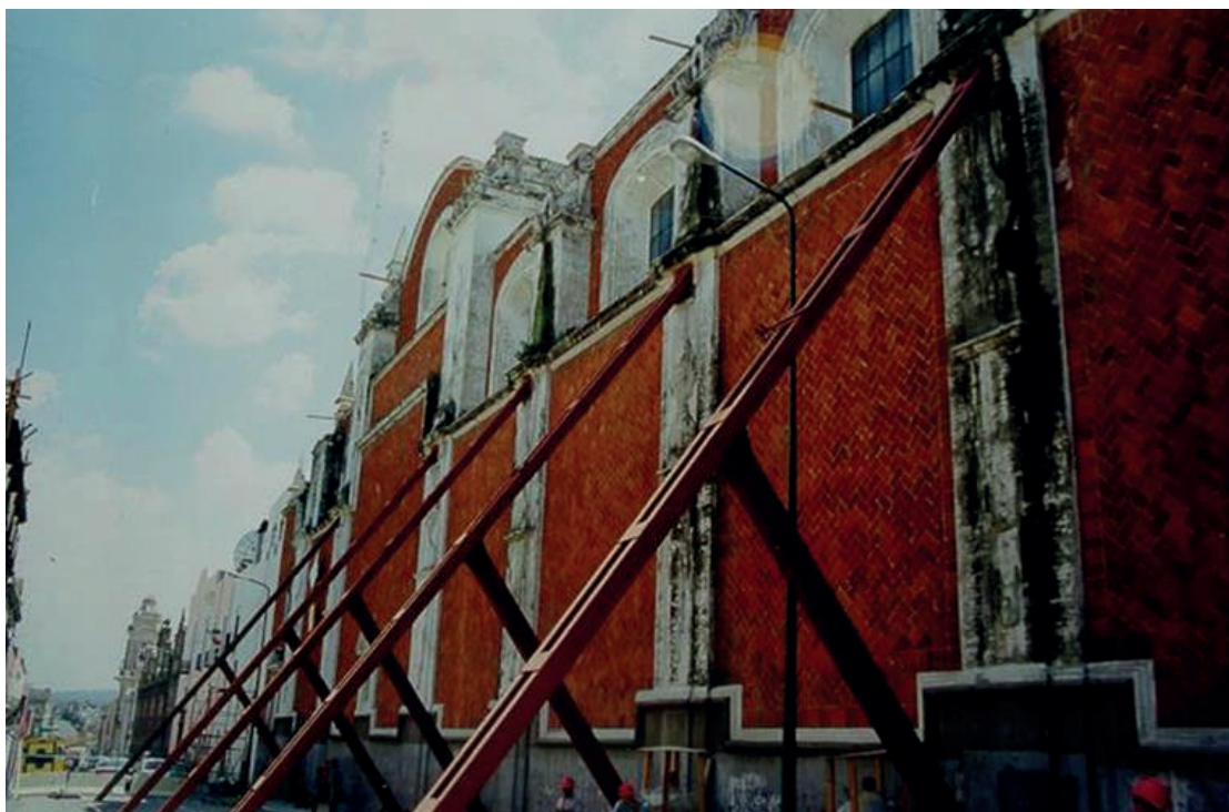
Imagen 1. Apuntalamiento de acero de la fachada norte del Templo de la Compañía de Jesús, Puebla, 1999. Fotografía: Empresa constructora Acrosa.
