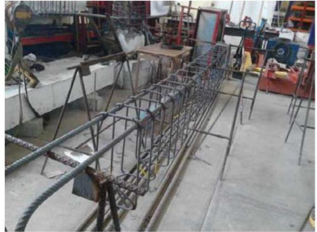
Figura A3. Acero longitudinal.
