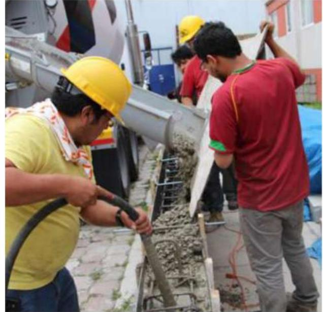
*Figura A7. Colado y vibrado de especímenes.*
