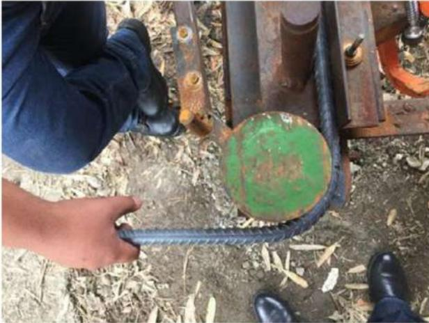
Figura A1. Doblado del refuerzo
