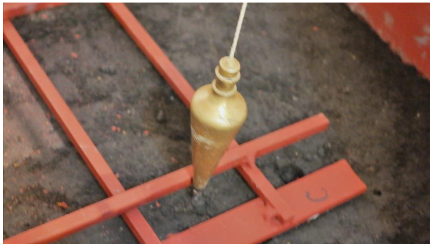
Figura 47. Placa guía para hincado de pilotes.
